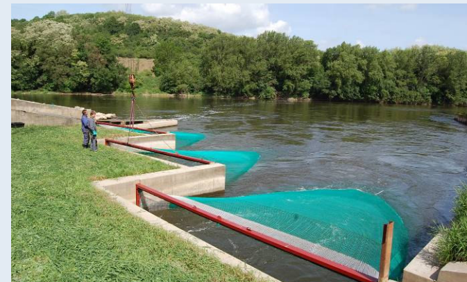
fangfertig gestellte Turbinenhamen, Foto: G. Ebel
