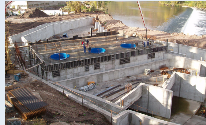
Wasserkraftanlage in der Bauphase, Foto: G. Rauch
