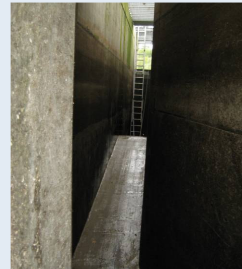
Überfallwehr im Bypass während der Bau- phase (im Hintergrund bauzeitl. Revisions- verschluss zum Unterwasser), Foto: A. Gluch
