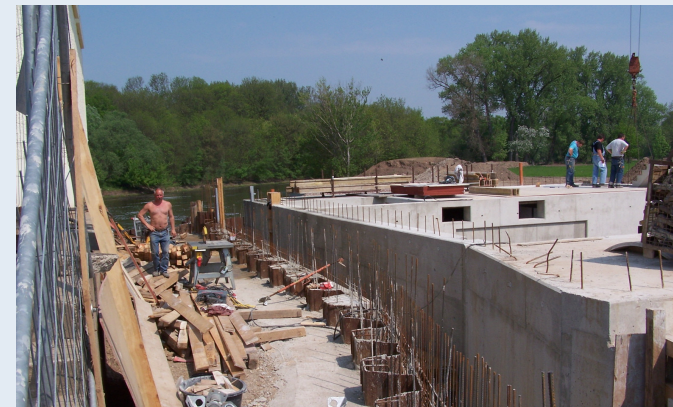
Bypass im Bau, Foto: M. Kehl
