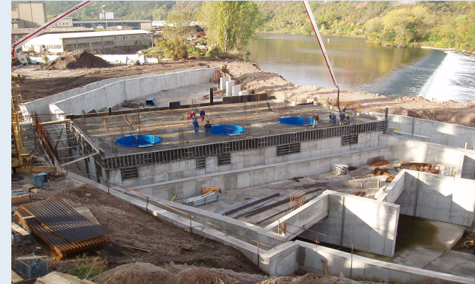
Buchtenkraftwerk mit Leitreechen-Bypass-System im Bau (Ausbaudurchfluss 68 m³/s), Foto: G. Rauch
