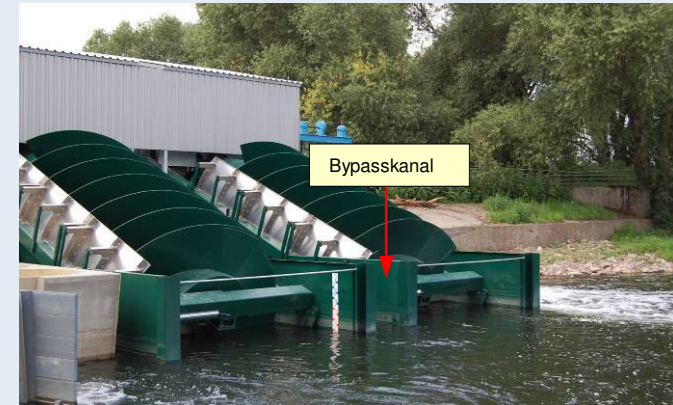
Unterwasseransicht der Wasserkraftanlage, Foto: G. Ebel
