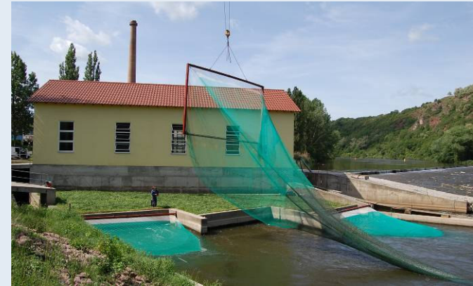
Installation Turbinenhamen, Foto: G. Ebel
