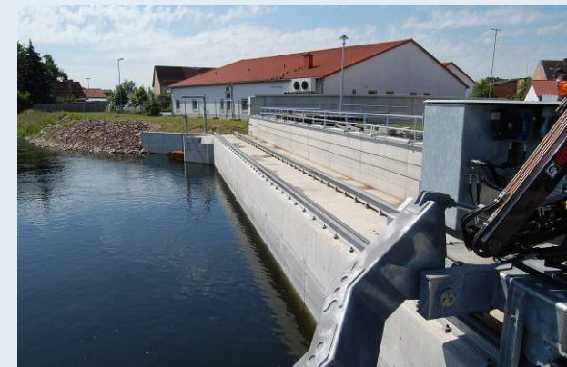
Rechen mit horizontaler Schräganströmung, Foto: G. Ebel
