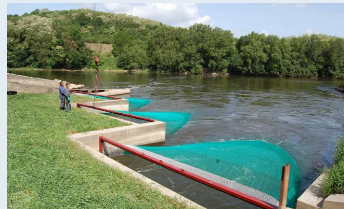
fangfertig gestellte Turbinenhamen, Foto: G. Ebel
