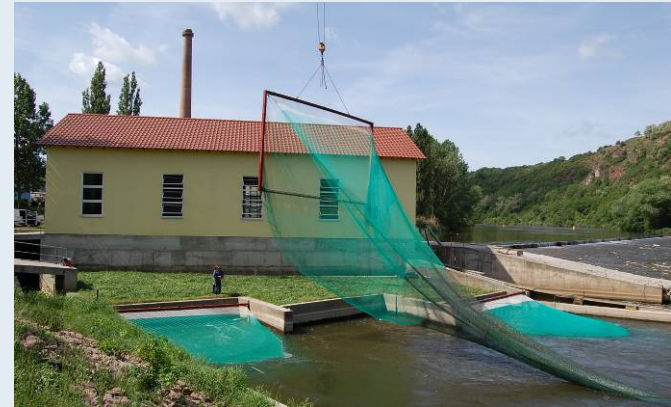
Installation Turbinenhamen, Foto: G. Ebel
