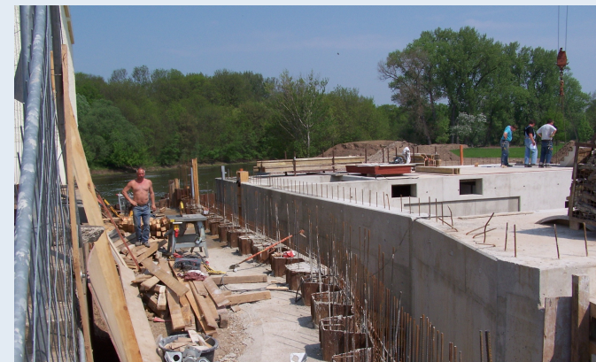
Bypass im Bau, Foto: M. Kehl
