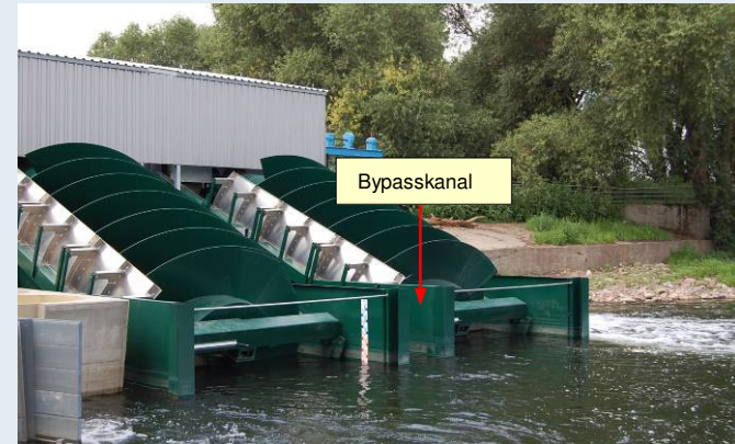
Unterwasseransicht der Wasserkraftanlage, Foto: G. Ebel
