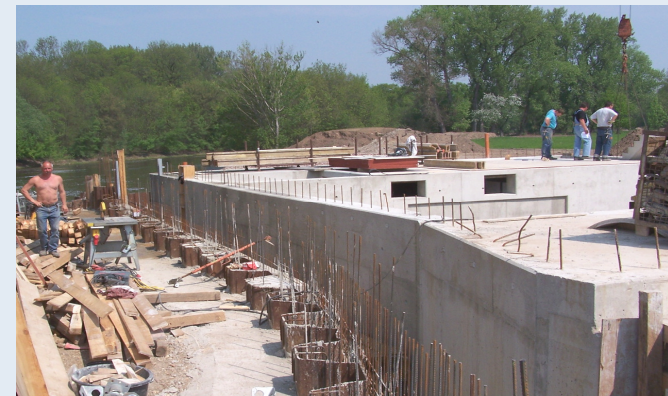
schachtartiger Bypass im Bau, Foto: M. Kehl
