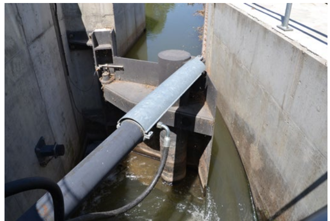
Bild 6: Schachtartige Bypässe mit selbstreinigenden Regelorganen ermöglichen bei geringem Unterhaltungsaufwand einen dauerhaft funktionssicheren Betrieb: Bypass im Bau, Blick zum Unterwasser (links), Eintrittsbereich eines Bypasses mit selbstreinigendem Tor im Betrieb, Blick zum Oberwasser (rechts)
