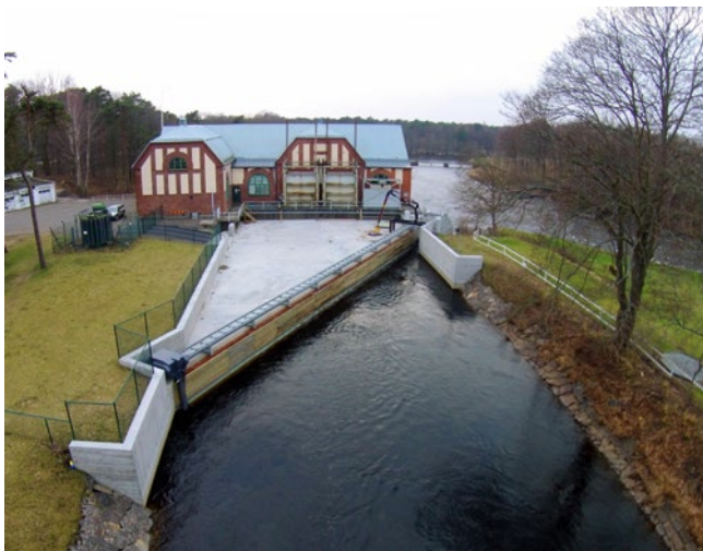
Bild 2: Detaillierte Untersuchungen zur biologischen Wirksamkeit von Leitrechen-Bypass-Systemen wurden beispielsweise an der WKA Falkenberg (Ätran, Schweden) ausgeführt, die einen Ausbaudurchfluss von 40 m³/s besitzt
