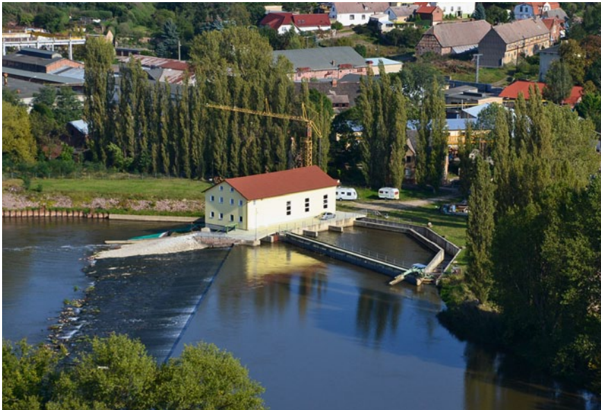
Bild 1: Die ingenieurbio- logische Auslegung von Fischschutz- und Fischabstiegssys- temen erfordert detaillierte Informationen zu den physischen Voraussetzungen und Verhaltensmustern abwan- dernder Fische; das Foto zeigt eine ingenieurbio- logisch konzipierte Wasserkraftanlage (Rothenburg/Saale, Ausbaudurchfluss 68 m 3 /s) mit Leitrechen-Bypass-System nach Ebel, Gluch & Kehl (2001) [1]
