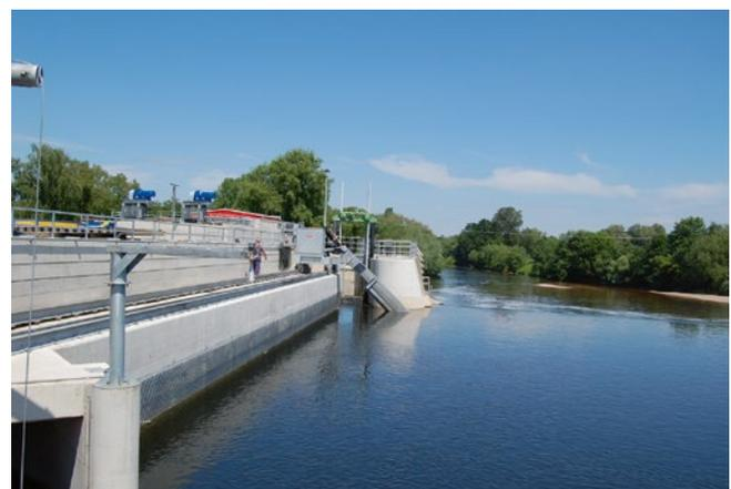
**Bild 3:** Leitrechen mit Sohleleitwand an einer Wasserkraftanlage mit einem Ausbaudurchfluss von 88 m<sup>3</sup>/s (links: im Bau, rechts: im Betrieb; Quellen: links: A. Gluch, rechts: G. Ebel)
