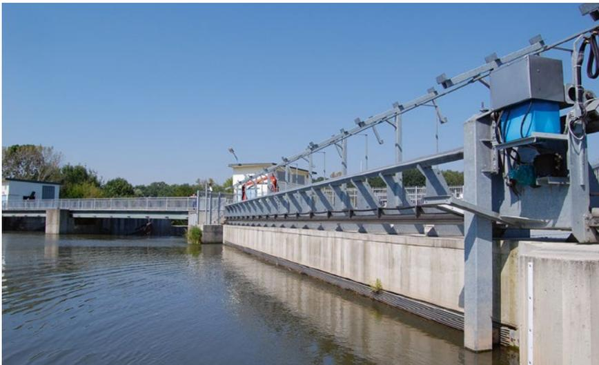
**Bild 1:** Das Leitrechen-Bypass-System wurde erstmals an der Pilotanlage Halle-Planena (Saale, Deutschland, Ausbaudurchfluss 50 m<sup>3</sup>/s) praktisch ausgeführt (Quelle: G. Ebel)
