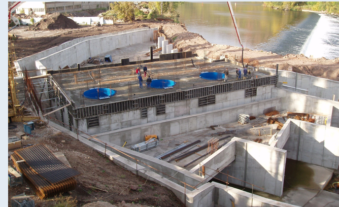
Wasserkraftanlage in der Bauphase, Foto: G. Rauch
