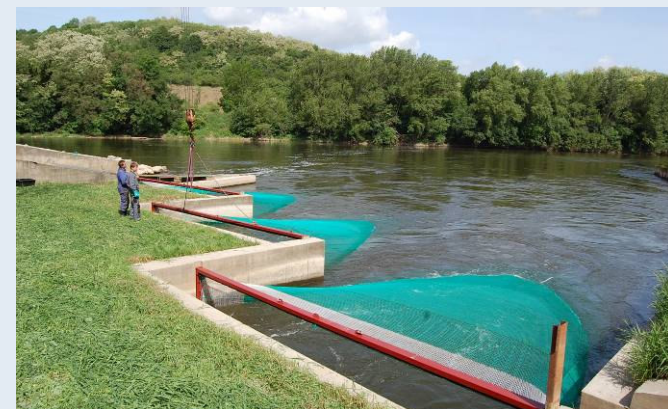
fangfertig gestellte Turbinenhamen, Foto: G. Ebel
