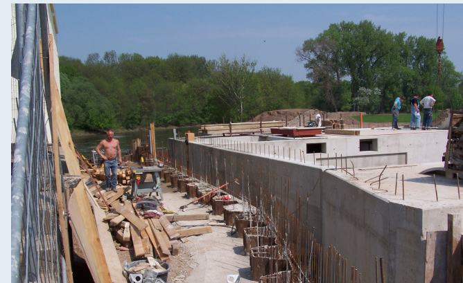
Bypass im Bau, Foto: M. Kehl
