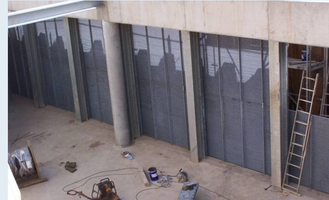
Rechen in der Bauphase (Ansicht Abströmseite), Foto: M. Kehl
