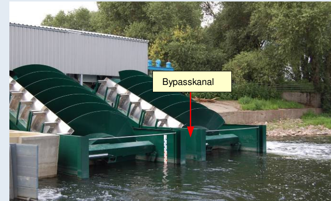
Unterwasseransicht der Wasserkraftanlage, Foto: G. Ebel
