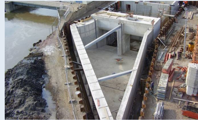
Pilotanlage Planena (Saale) im Bau, Foto: M. Kehl
