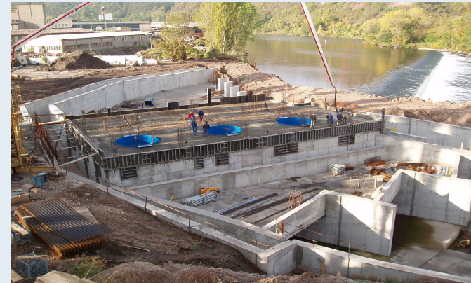
Buchtenkraftwerk mit Leitreechen-Bypass-System im Bau (Ausbaudurchfluss 68 m 3 /s), Foto: G. Rauch
