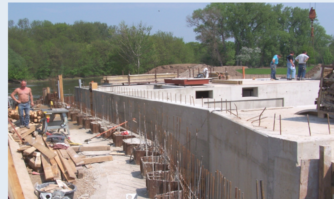
schachtartiger Bypass im Bau, Foto: M. Kehl
