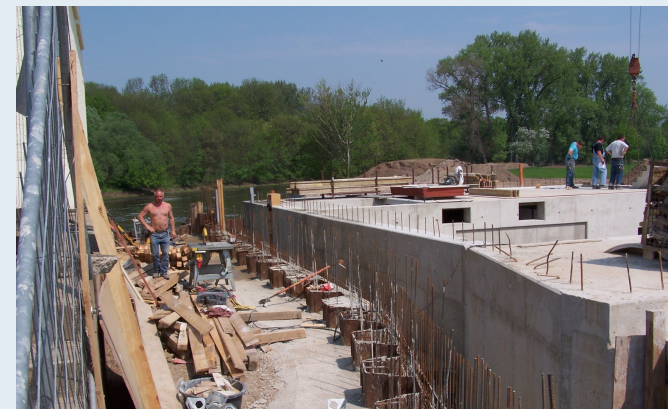
Bypass im Bau, Foto: M. Kehl
