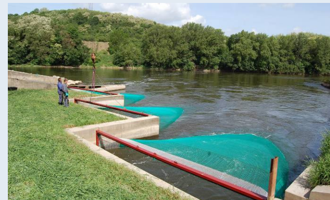
fangfertig gestellte Turbinenhamen, Foto: G. Ebel
