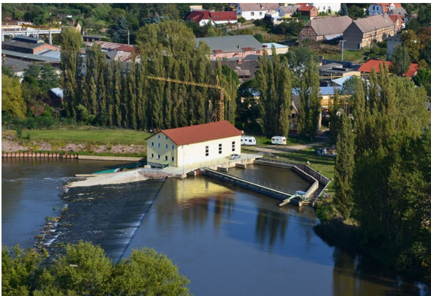
Bild 1: Die ingenieurbio- logische Auslegung von Fischschutz- und Fischabstiegssys- temen erfordert detaillierte Informationen zu den physischen Voraussetzungen und Verhaltensmustern abwan- dernder Fische; das Foto zeigt eine ingenieurbio- logisch konzipierte Wasserkraftanlage (Rothenburg/Saale, Ausbaudurchfluss 68 m 3 /s) mit Leitreechen-Bypass-System nach Ebel, Gluch & Kehl (2001) [1]
