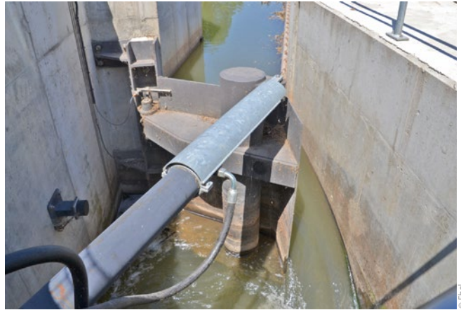
Bild 5: Beide WKA sind mit lichtoffenen, schachtartigen Bypässen ausgestattet, deren Eintrittsprofil die gesamte Höhe der Oberwassersäule erfasst: Bypass der WKA Öblitz im Bau (Blick zum Unterwasser) (links), Bypass der WKA Freyburg (Eintrittsbereich mit Klappe) im Betrieb (rechts)
