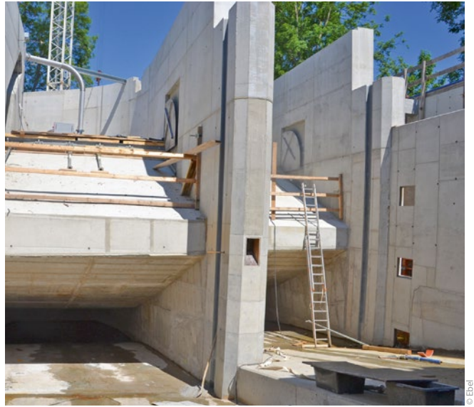
Bild 7: Beckenstruktur (links) und turbinennahe Einstiegsmöglichkeiten (rechts, rechter Bildbereich) des Schlitzpasses der WKA Öblitz
