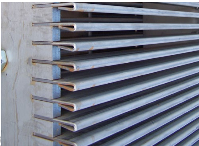
Bild 4: Detailansicht der eingesetzten 10-mm-Rechen: WKA Freyburg (links), Muster WKA Öblitz (rechts)
