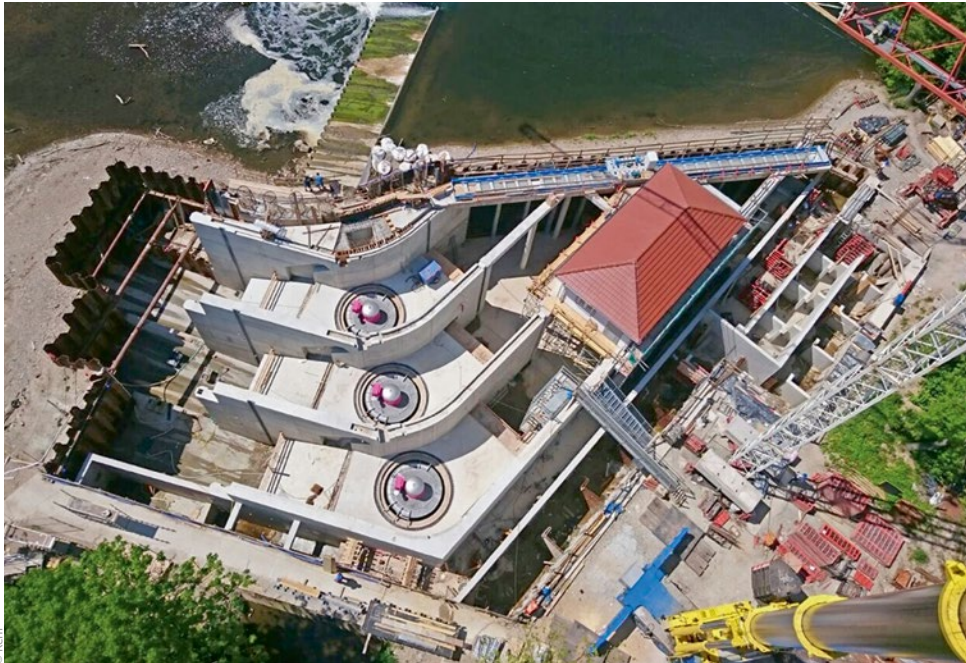
Bild 3: WKA Öblitz mit Leit-rechen-Bypass-System im Bau
