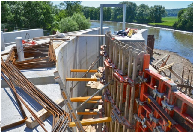
Bild 5: Beide WKA sind mit lichtoffenen, schachtartigen Bypässen ausgestattet, deren Eintrittsprofil die gesamte Höhe der Oberwassersäule erfasst: Bypass der WKA Öblitz im Bau (Blick zum Unterwasser) (links), Bypass der WKA Freyburg (Eintrittsbereich mit Klappe) im Betrieb (rechts)
