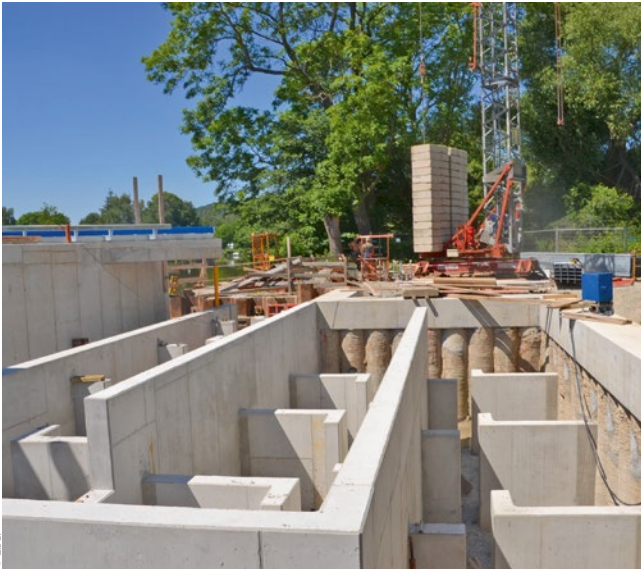
Bild 7: Beckenstruktur (links) und turbinennahe Einstiegsmöglichkeiten (rechts, rechter Bildbereich) des Schlitzpasses der WKA Öblitz
