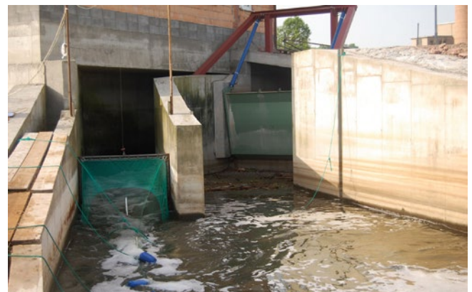
Bild 4: Netzartige Fanggeräte wurden beispielsweise am Standort Rothenburg für die Ermittlung der biologischen Effizienz eingesetzt: Hamen im Austrittsprofil der Saugrohre (links), Schwalgreuse im Austrittsprofil des Bypasses (rechts)
